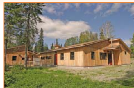
Station de recherche de la FERLD
