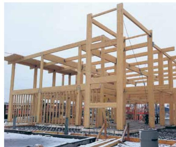
Construction d'un bâtiment utilisant le système poteaux-poutres en bois lamellé-collé. – Photo : Joël Siroard
