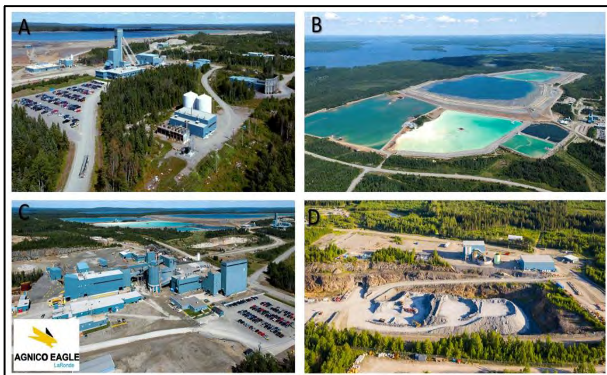
Figure 15 : Vue d'ensemble des infrastructures minières de LaRonde, (Agnico Eagle Ltée, 2023)
