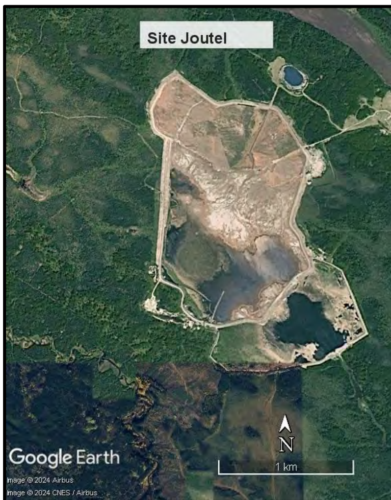
Figure 17 : Vue aérienne du site Joutel sur image Google Earth (2024).
