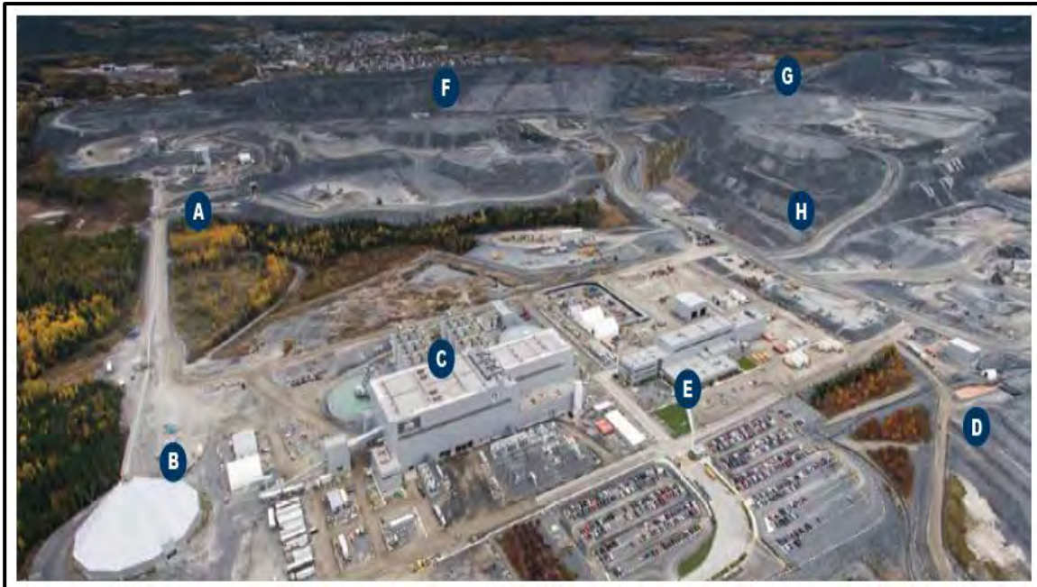
Figure 13 : Vue d'ensemble des infrastructures minières de Canadian Malartic, (Arseneault et al., 2021). A= Zone de concassage, B= Zone d'entreposage du minerais, C=Usine de traitement du minerais, D=Parc a résidus, E=Bureaux et garage, F= Fosse Canadian Malartic, G=Fosse barnat, H=Halde stérile.
