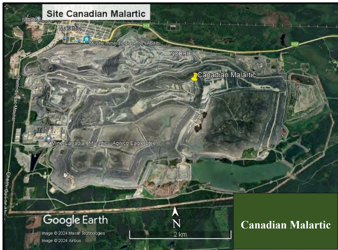
Figure 12 : Vue aérienne du site minier de Canadian Malartic sur image Google Earth (2024).
