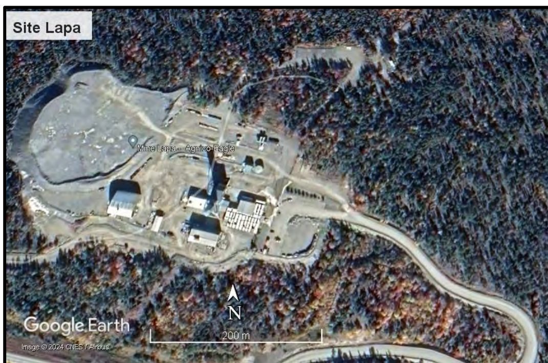
Figure 16 : Vue aérienne du site Lapa sur image Google Earth (2024).
